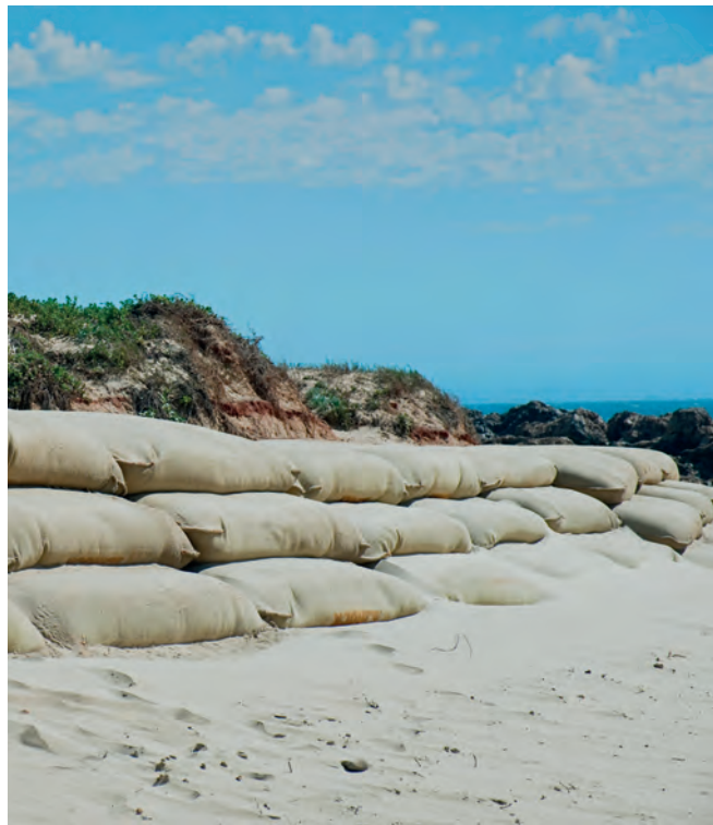
01 Sacs de sable sur une plage empêchant l'érosion du sol à marée haute et aux jours de tempête.
